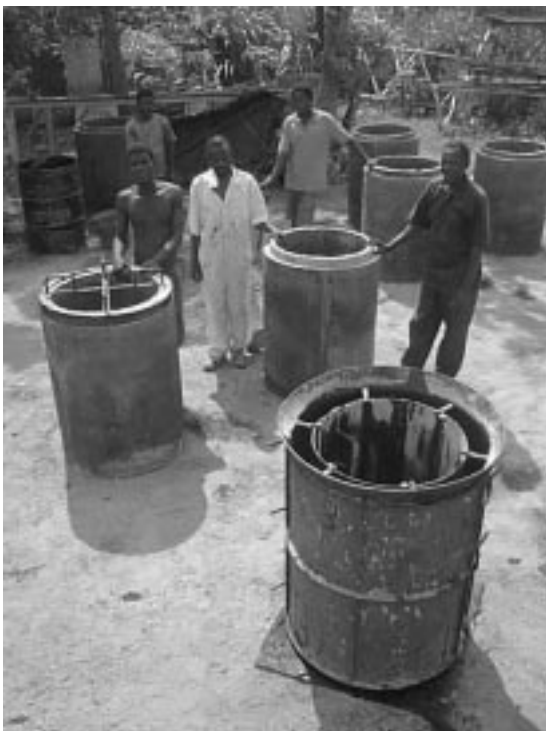
Culvert casting, Centre de Formação (CFE), Mozambique
