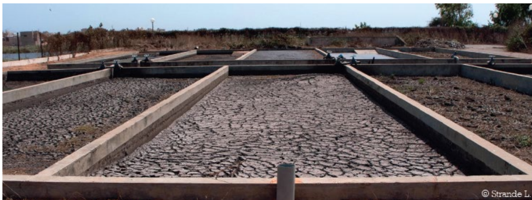
Gráfico 2.3.3. Lechos de secado en la planta de tratamiento de lodos fecales Niayes, en Dakar, Senegal.
